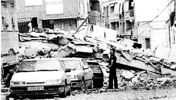
Das Beben vom Mai 2011 zerstörte zahlreiche Gebäude und riss neun Menschen in den Tod.
